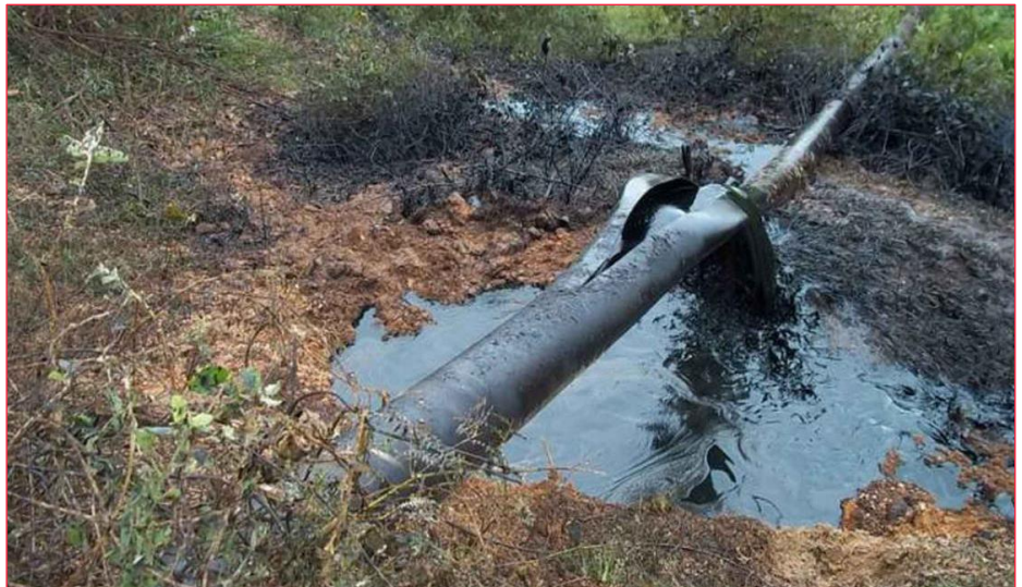
Tramo de oleoducto afectado por la instalación de válvulas ilícitas para el hurto de hidrocarburos. 15.09.2020
